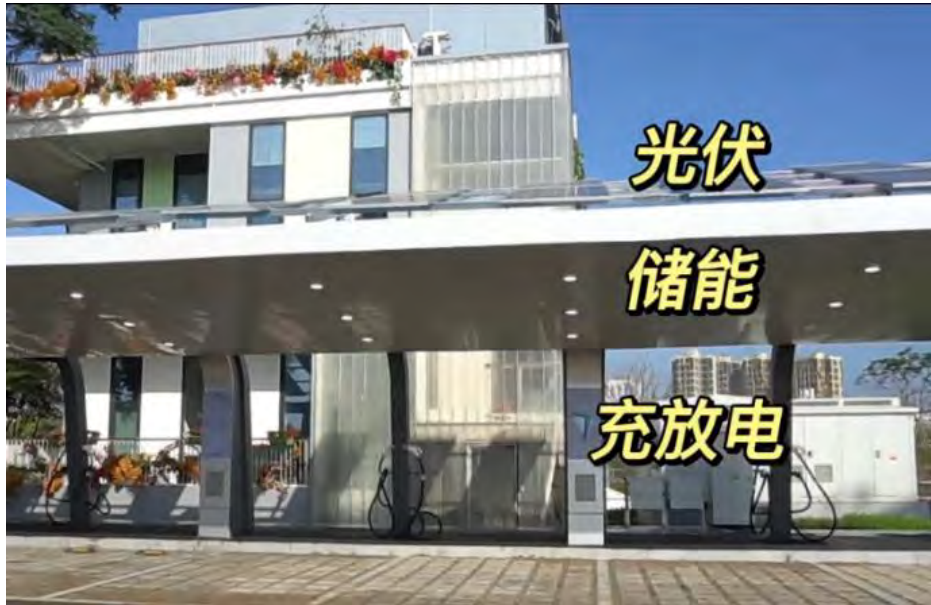
图 47 光储充放一体化电站
